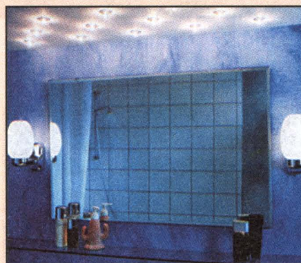
«Звёздное небо» в ванной, созданное с помощью миниатюрных лампочек мощностью до 10 Вт. Здесь использованы лампочки без рефлекторов.
