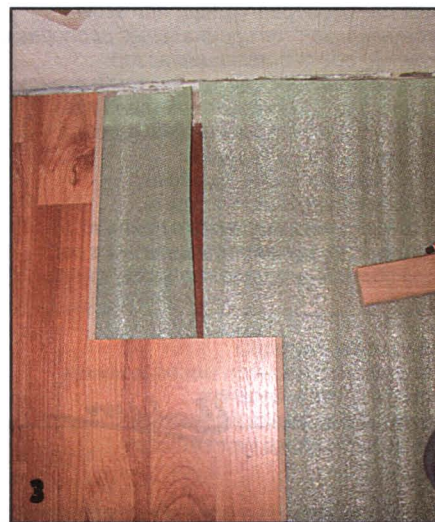
Подложку раскладывают без нахлёста и даже с небольшим зазором.
