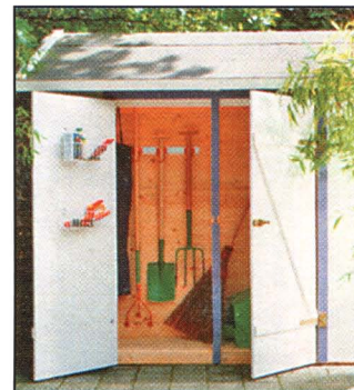
Сарайчик для садового инвентаря с тремя помещениями. Центральный отсек — шириной 1200 мм, в нём можно хранить велосипеды и тачку. Слева и справа от него предусмотрены отсеки глубиной по 400 мм для хранения остального садового инвентаря.
