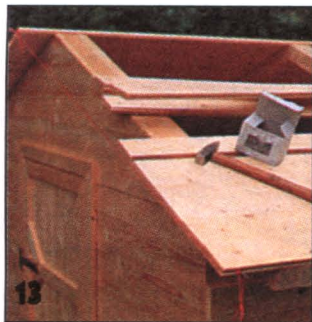
13 К стропилам, усиленным с боков брусками сечением 40х60 мм, прибивают гвоздями нестроганные шпунтованные доски — настил под кровлю.
