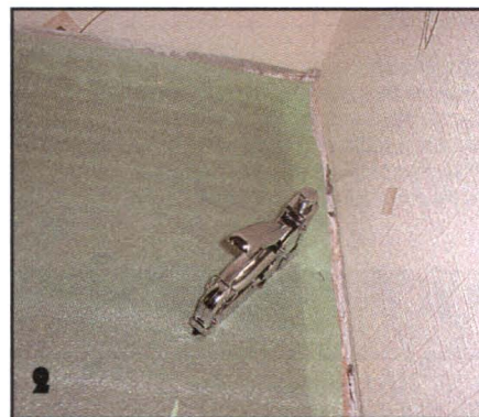
...по краю её можно закрепить скобками с помощью степлера.
