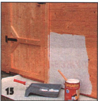
15 Снаружи сарайчик покрывают краской для наружных работ. С обеих сторон красят только двери.
