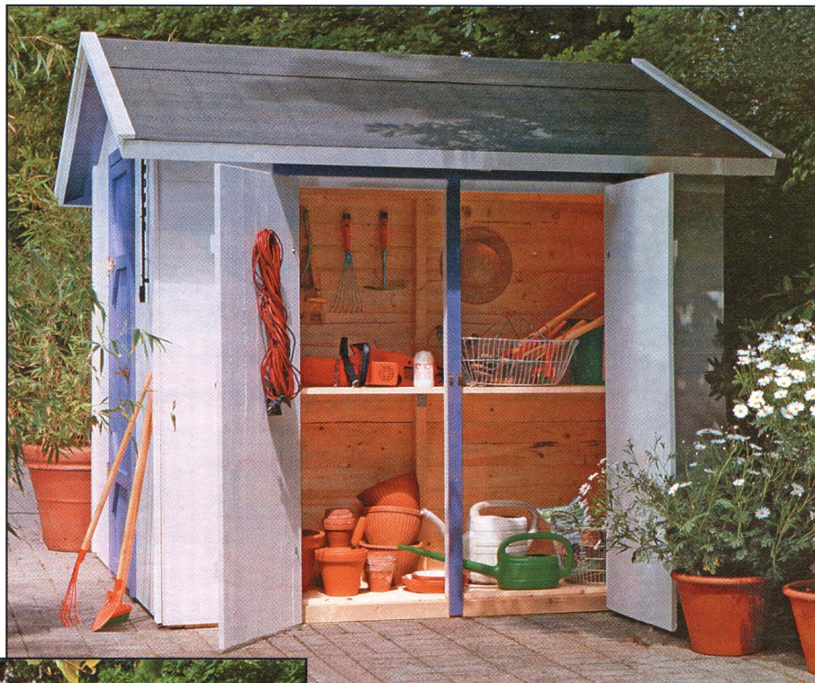
Сарайчик для садового инвентаря с тремя помещениями. Центральный отсек — шириной 1200 мм, в нём можно хранить велосипеды и тачку. Слева и справа от него предусмотрены отсеки глубиной по 400 мм для хранения остального садового инвентаря.
