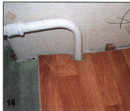
Монтируют панель. Обратите внимание на зазор ~ 10 мм вокруг трубы до панели.
